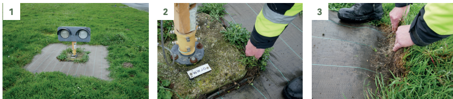
1. Pied de balise réaménagé avec la toile stabilisée. 2. et 3. Opération d'arrachage manuel de la végétation des bords de toile en début de saison. Aéroport de Dinard
