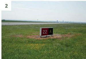
1. Balise lumineuse basse traitée au désherbant total deux fois par an. Aéroport d'Orléans ©Aéroport d'Orléans. 2. Panneau de signalétique avec socle béton dont le pourtour est traité au désherbant total une à deux fois par an. Aéroport de Beauvais
