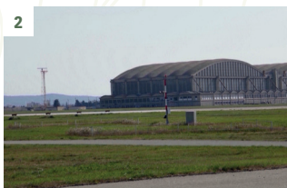
1. Végétation laissée « haute » en pied de clôture de glide path et 2. mat anémométrique. La délimitation de la zone est d'autant plus marquée visuellement grâce à la rupture de hauteur de végétation. Aéroport de Marseille
