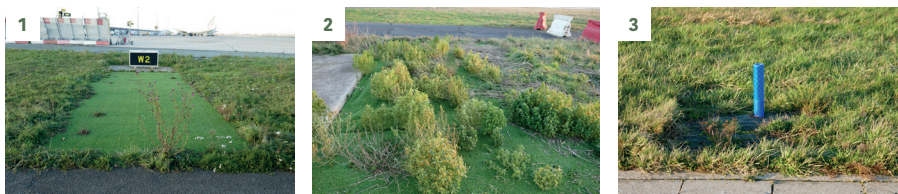
1. et 2. Revêtement de gazon synthétique avec ou sans sous-couche de géotextile. 3. Essai non concluant de pose d'un grillage en pied de balise. Aéroport d'Orly
