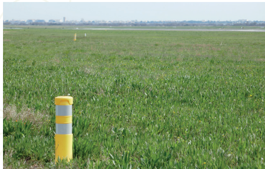
Marquage de la zone sensible autour du localizer à l'aide de balise de signalétique routière. Le même marquage est utilisé autour du glide. Aéroport de Montpellier
