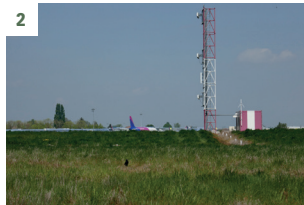
1. et 2. Clôtures avec poteaux bas et chaînette unique, dont le pied de clôture est traité au désherbant total une à deux fois par an. Aéroport de Beauvais.
