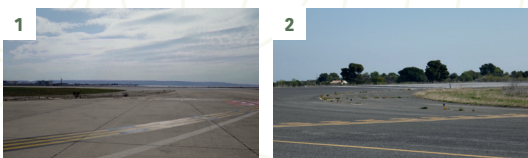
1. Acceptation de la flore spontanée dans les fissures en bord de voies aéronautiques. Aéroport de Perpignan 2. Acceptation de la flore spontanée dans les fissures en bord de voies aéronautiques. Aéroport de Marseille
