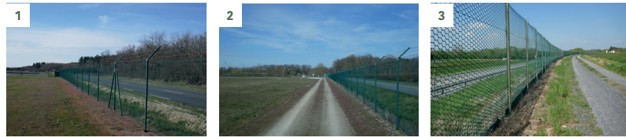
1. Clôture de sûreté traitée au désherbant total deux fois par an sur une bande intérieure de plus de 80 cm. Aéroport d'Orléans
