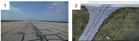
1. Rendu visuel d'une piste après réalisation d'opérations de pontage. Aéroport de Marseille 2. Vue aérienne d'un taxiway et de ses opérations de pontage. Aéroport de Montpellier - Crédit photo © Google Earth.
