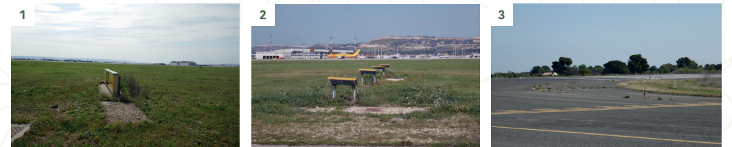
1. Végétation laissée plus haute autour des pieds de PAPI et 2. derrière les panneaux de signalétiques. Aéroport de Marseille. Végétation spontanée entre les fissures des bords de piste et taxiway. 3. Seule est coupée la végétation qui empêche la visibilité des balises. Aéroport de Perpignan
